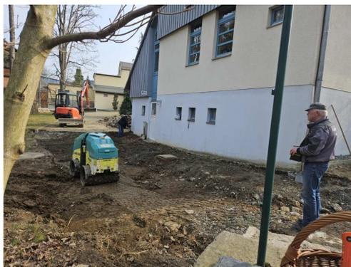
Aktuell wird die neue Zuwegung zum Park hinter dem Pfarrhaus angepasst. Hier musste ebenfalls das Höhenniveau angepasst werden, um Sturzkanten zu beseitigen und einen besseren Wasserablauf bei Starkregen zu ermöglichen. Hierzu werden die seit einigen Jahren defekten Regenentwässerungsleitungen ausgetauscht. Abschließend wird das Gelände wieder mittels Gartenzaun eingefriedet. Im Kirchhof muss neuer Wegekies aufgezogen werden.
