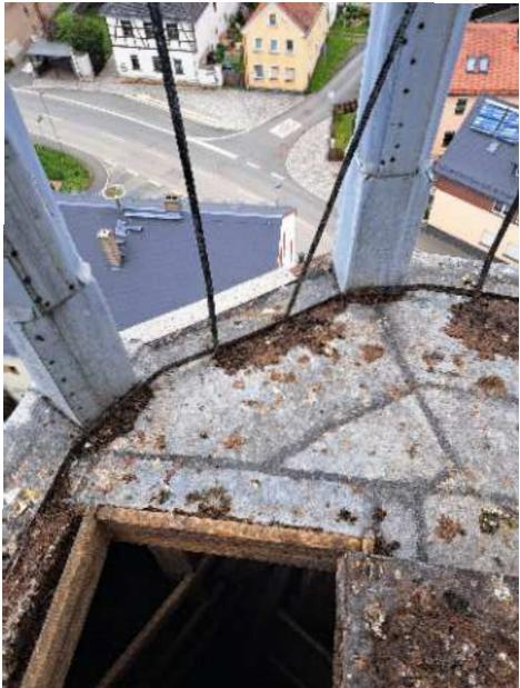
Leider sind zwischenzeitlich akute Schäden an der Verblechung der Laterne oberhalb der Turmhaube aufgetreten. Hier dringt massiv Wasser in die darunterliegende Turmhaube ein und ist bereits bis in die sanierte Glockenstube mit dem neuem Eichenholzglockenstuhl vorgedrungen.
