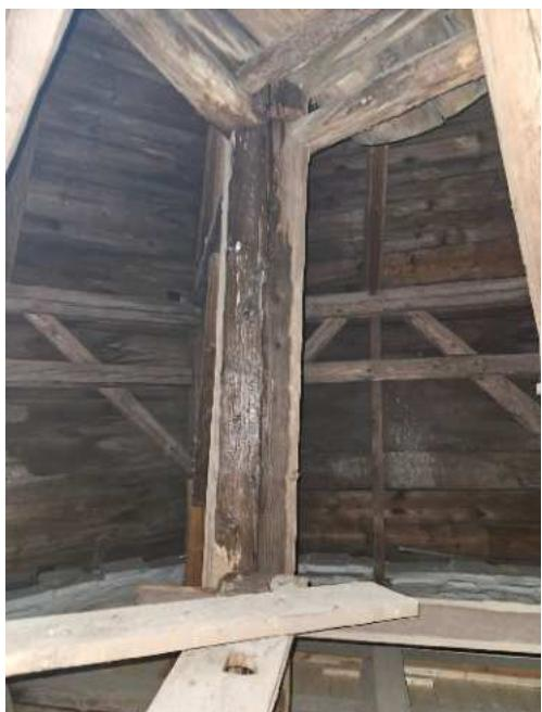
Durch das Eindringen des Wassers sind bereits starke Schäden am Turmgebälk, insbesondere an den Stielen der Laterne und den Zwischenböden (Absturzgefahr), entstanden.
